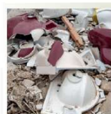
Les gravats ou déchets de même nature (Béton, Faïence, Wc ou lavabo, Tuiles)
